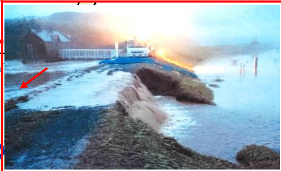
常呂川の堤防崩れ(北見市)
