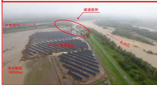
札内川の堤防決壊状況(帯広市)
