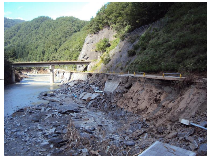
国道455号の道路被害状況(二升石地区)
