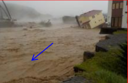
十勝川水系ペケレベツ川の被害状況(清水町)
