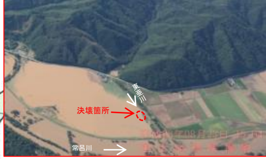
常呂川水系東亜川の被害状況(北見市)
