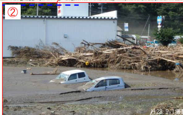
流入した土砂による車の埋没状況
