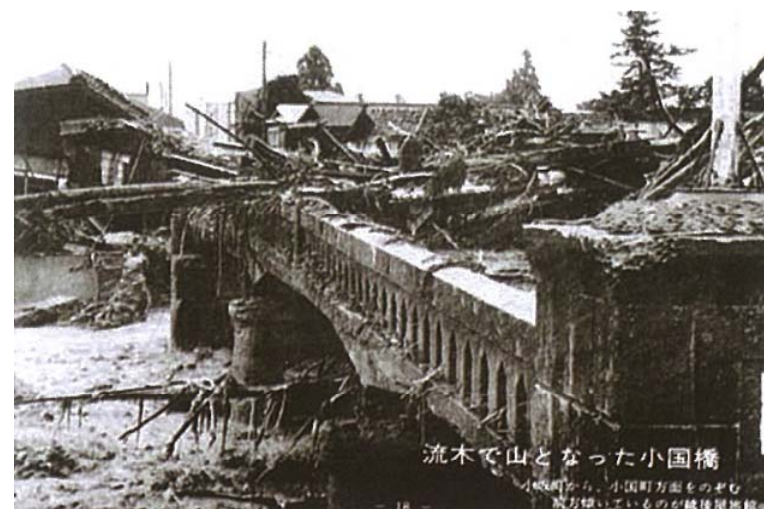
小国橋に流木が堆積した状況
