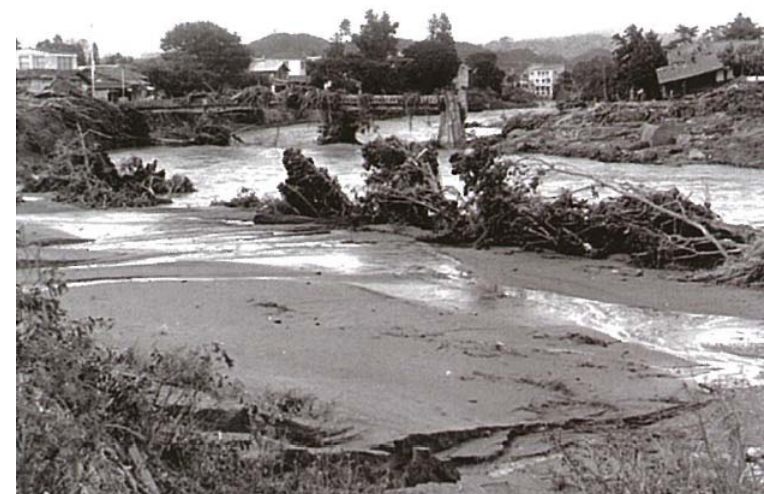
流木が堆積した小国橋(横川)
