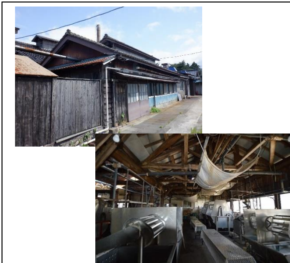
染色棟（旧染色室及び旧気罐室）
