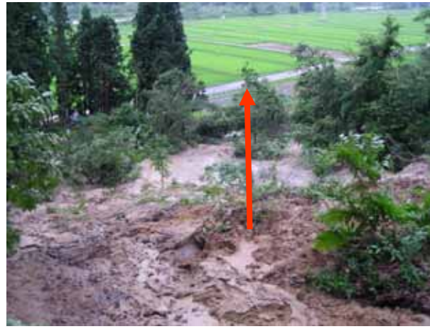
被災斜面上部より下部を望む
