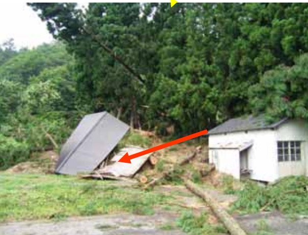
作業小屋被災状況
