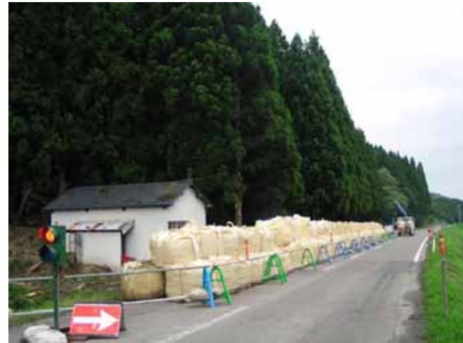
県道大中島・工藤沢線応急工事状況
