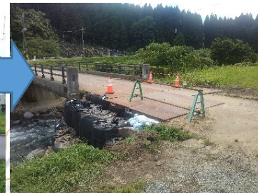
8/1 14:00時点 土のうによる応急復旧 片側交互通行可能
