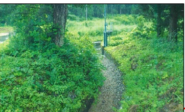
用水路の土砂堆積(小国町朝篠 7/26)
