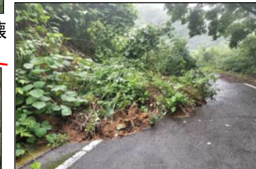
大石田町 林道小平線 法面崩壊
