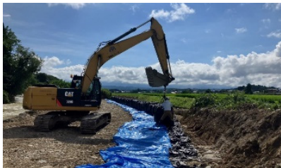
応急堤防工事中(7/30～)
