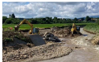
応急堤防工事の準備・整地(7/31～)
