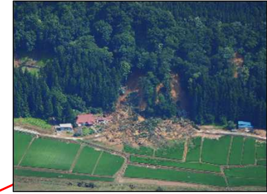
戸沢村松坂 山腹崩壊
