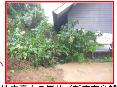
敷地内裏山の崩落 (新庄市鳥越 7/26) ※畜産研究所
