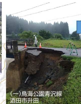
8/1 14:00時点 土のうによる応急復旧 片側交互通行可能
