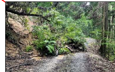
上山市 林道龍沢線 法面崩壊
