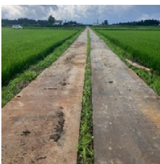
工事用道路完了(7/30)
