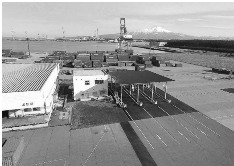
〈高砂ふ頭 コンテナ管理上屋〉
