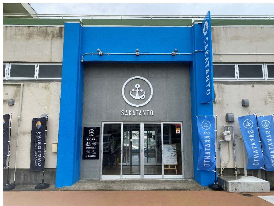
〈令和4年9月にオープンした東ふ頭交流施設「SAKATANTO」〉
