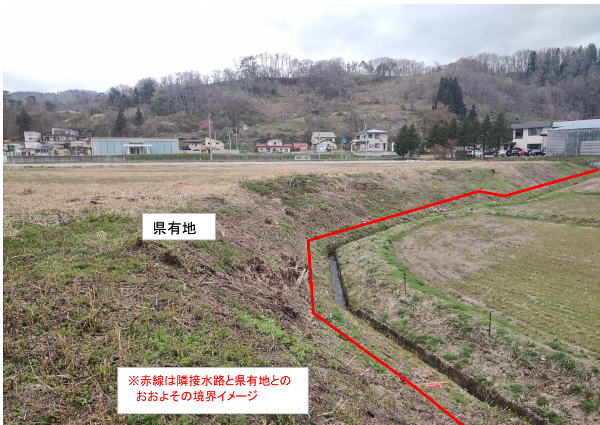
土地の東側法面 中心部付近から北方向を撮影
