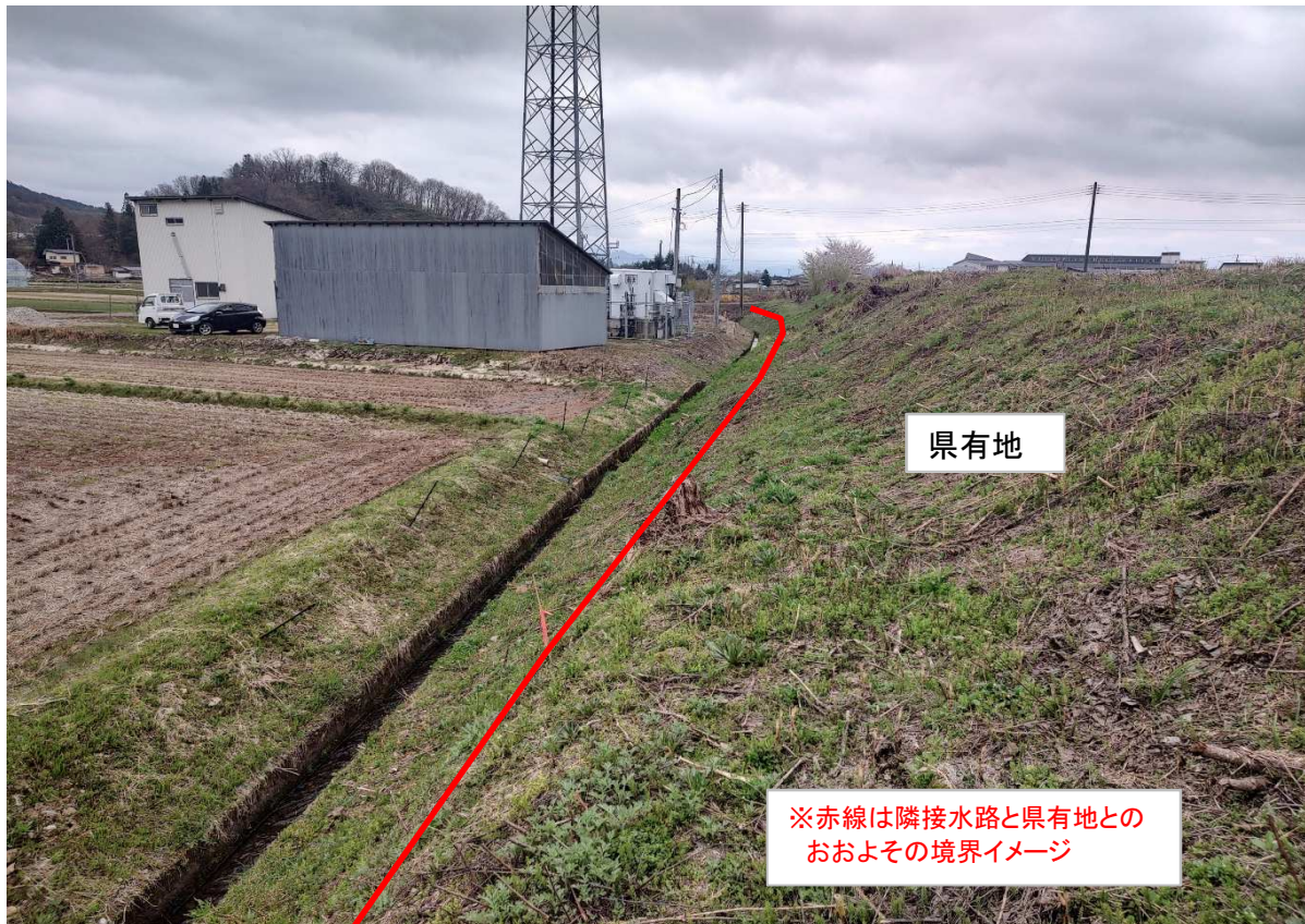
土地の東側法面 中心部付近から南方向を撮影
