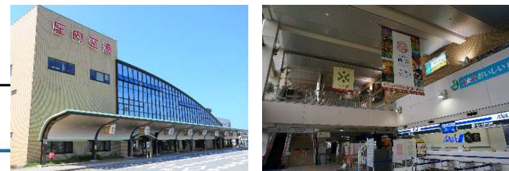
写真. Ⅲ-5-1 庄内空港ビル現有施設写真
