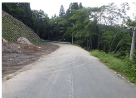
法面崩落土砂の撤去 (主)山形白鷹線(山形市村木沢)
