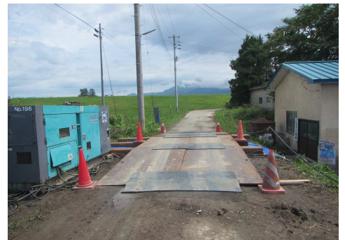
下釜排水機場の仮復旧の様子(河北町谷地)
