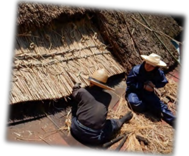
茅葺き調査(橋本屋)
