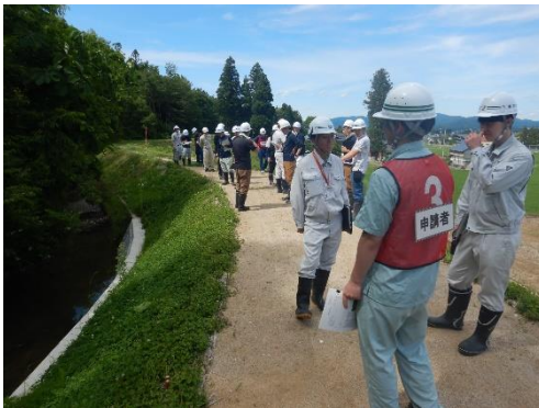
令和4年に被災し、復旧が完了した長堀排水路
