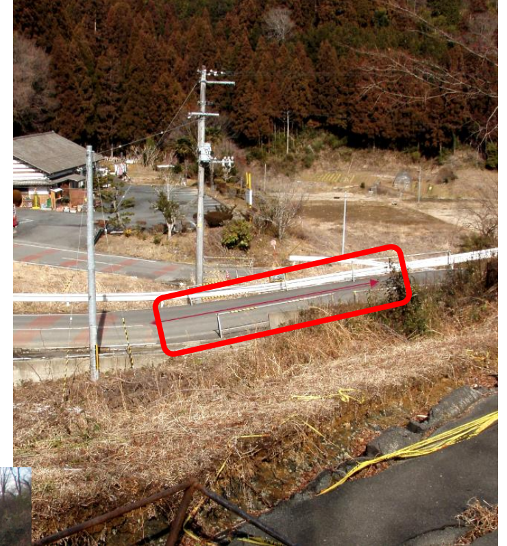
2011.3.11の余効とされる 4.11福島県浜通り地震で生じた 井戸沢断層の道路段差
