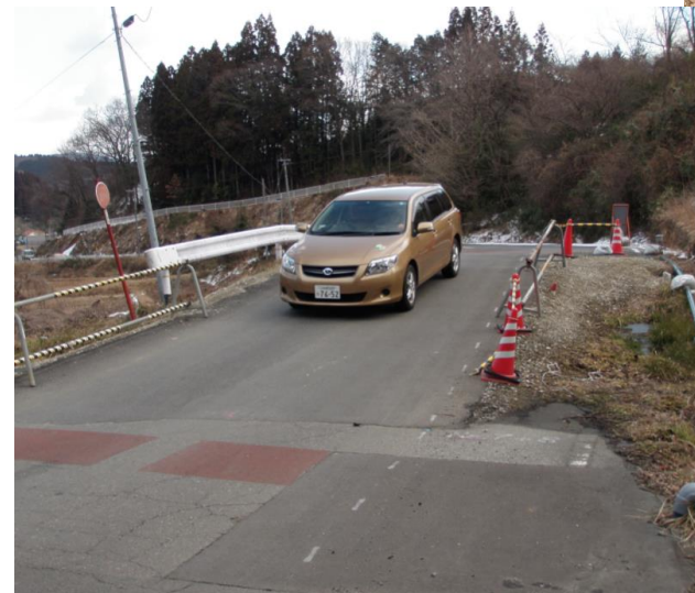
2011.3.11の余効とされる 4.11福島県浜通り地震で生じた 井戸沢断層の道路段差
