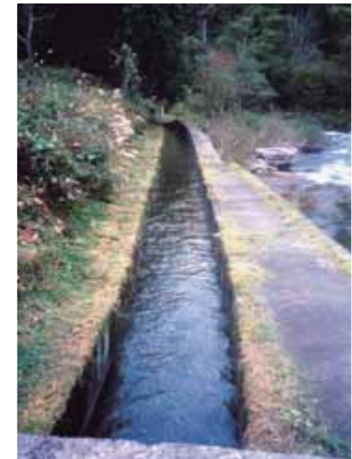
コンクリートになった水路
