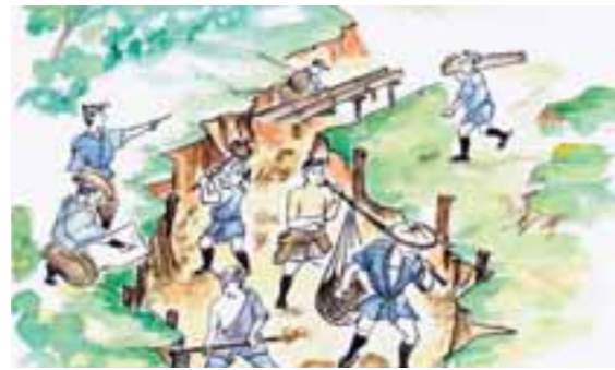
昔の水路を作るところ (白川土地改良区所蔵)
