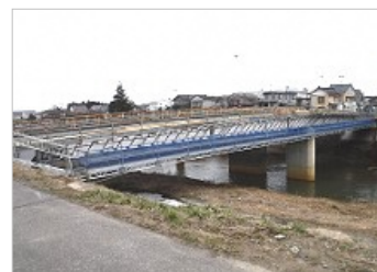
完成間近の新町橋歩道橋
