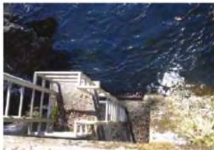
<越中堰頭首工 農業用水取入口です>
