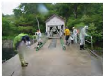
水門格納庫の雪囲いを外し、以東岳への登山道ともなっている堰堤に手すりを設置
