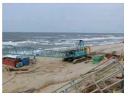
放流工の作業状況
