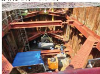
推進管吊り下ろし
