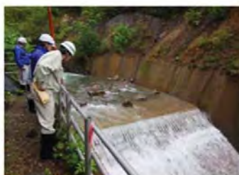
河床直接取水(バースクリーン工法)
