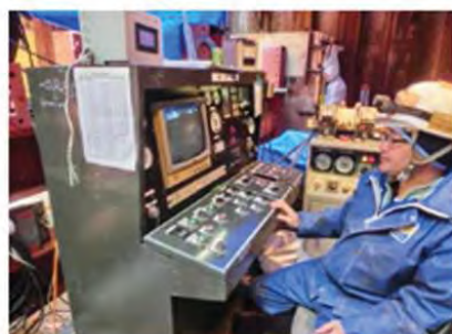
掘削マシンの向き等を管理し掘り進める
