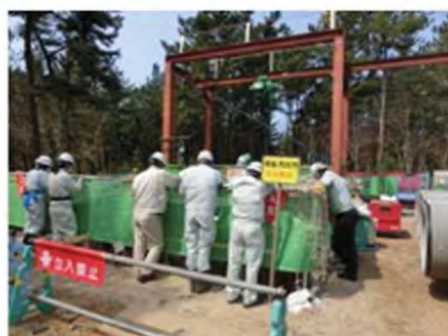
管路接続状況を上から見学
