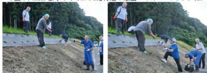
植栽して3年経過した法面からポットに株分けし、法面上部に植栽
