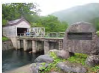
水門格納庫の雪囲いを外し、以東岳への登山道ともなっている堰堤に手すりを設置
