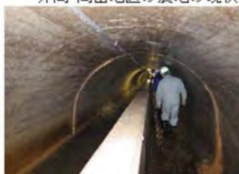
天保堰 トンネル部分
