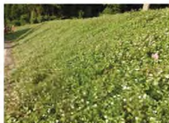
3年経過した法面
