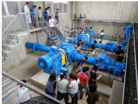
ポンプの大きさにびっくり
