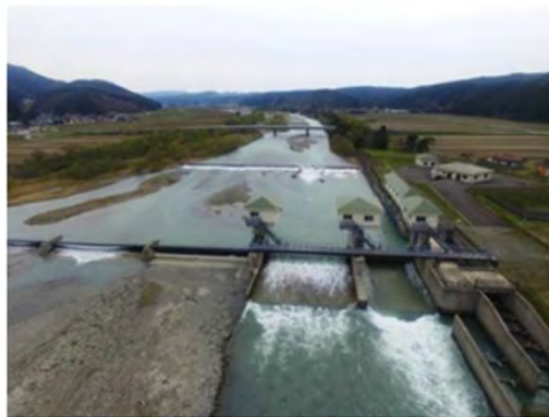
立谷沢川から取水する北楯頭首工
