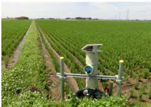
設置状況(給水側)
