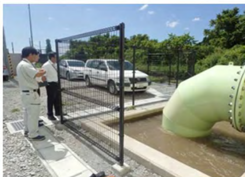
導水管の確認
