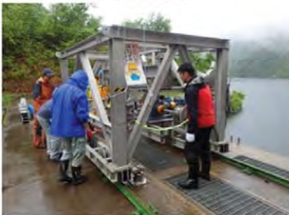
雪囲い外し作業
