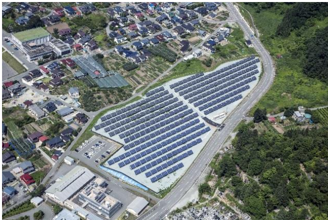
県営太陽光発電所 (H25. 12 運転開始)
