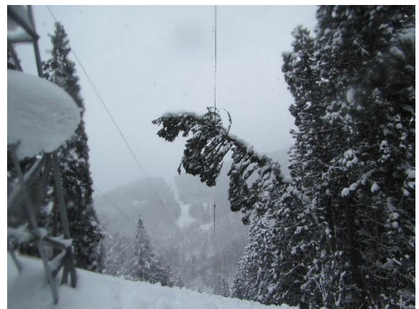
雪害 (朝日川連絡送電線)
