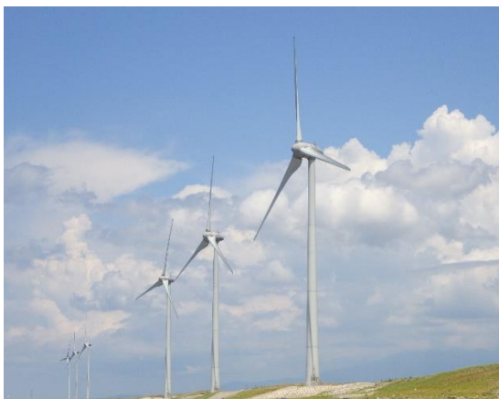
県営酒田風力発電所 (R3. 4 運転開始)
