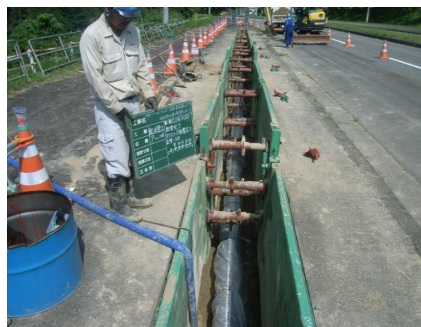
八幡原工業用水道 管路耐震化工事
