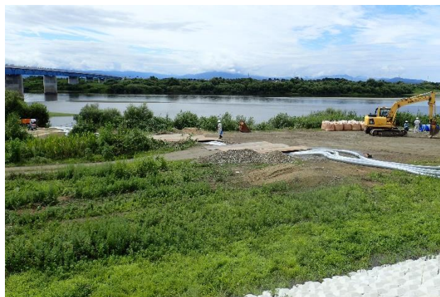
酒田工業用水道 仮設取水
