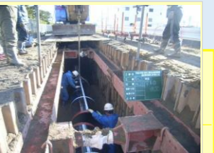
送水管耐震化工事(酒田工業用水道)
