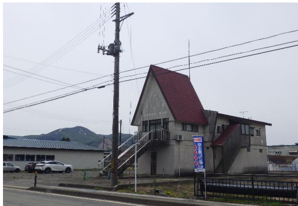
外観・近景（北西から南東）
