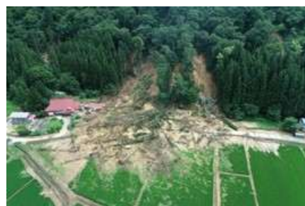
大雨による被災状況
