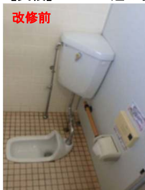
トイレの改修 和式トイレを洋式(高機能)トイレに改修
