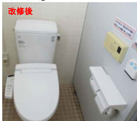
トイレの改修 和式トイレを洋式(高機能)トイレに改修
