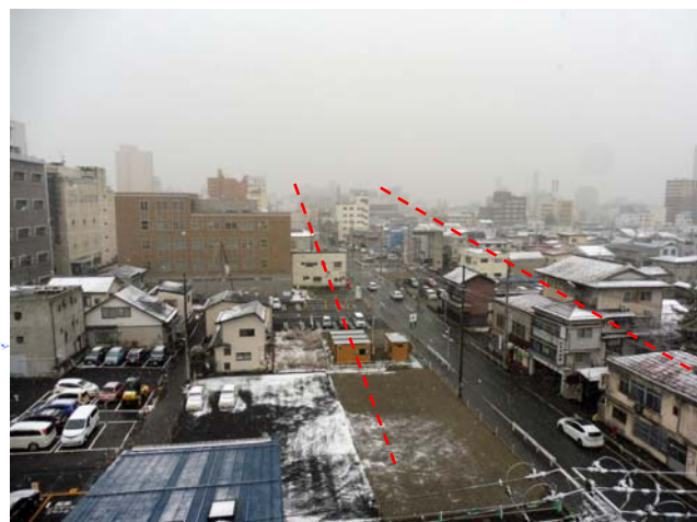
事業進捗状況（R2.1）北から南を望む
