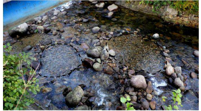
図2 造成した人工産卵床（破線部）
