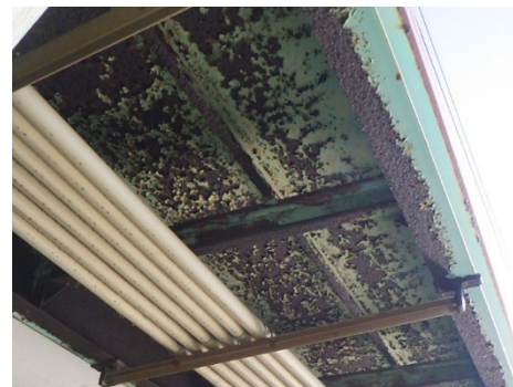
桁の損傷状況及び歩道下の腐食
