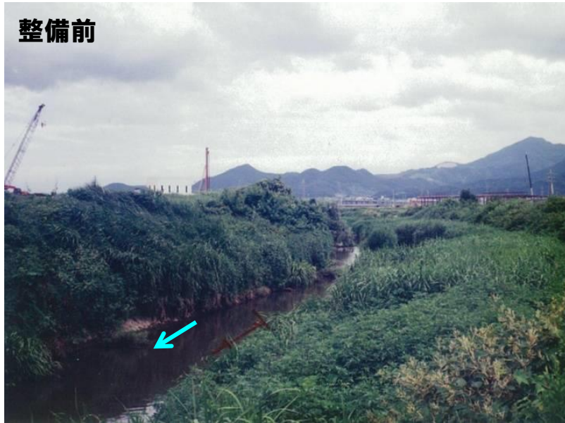
【最上川合流点より上流1.0km付近】:写真②
