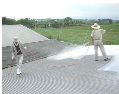
石灰の吹きつけ
