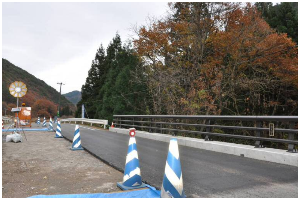
小湊橋 「長寿命化計画」に基づき補修工事中(平成24年11月の状況)。
