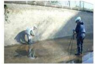
サーモグラフィによる水路壁面調査
