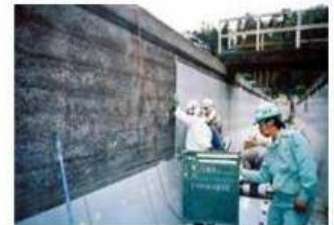
FRPM板取り付けによる断面補強
